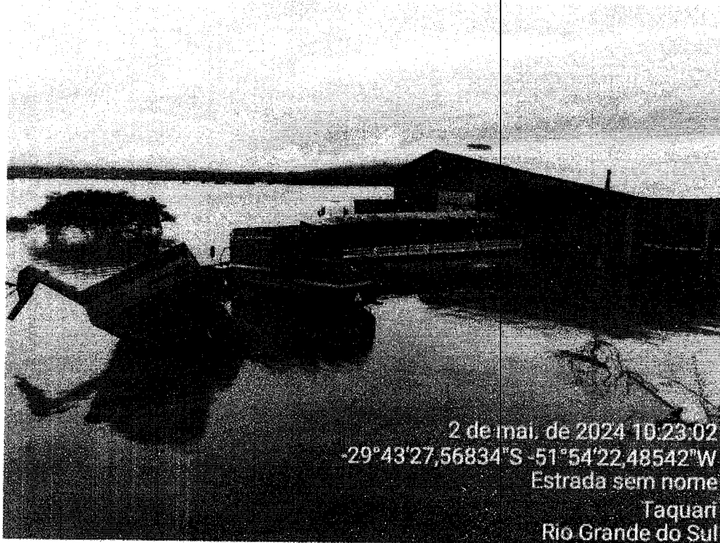
Imagem 02 – Arroio do Potreio – Galpão armazenamento de arroz e máquinas agrícolas
