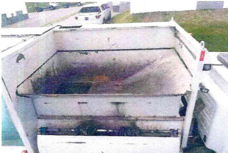
Foto 02 – Abertura para descarga resíduos
